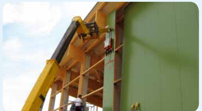
Montage von Wandpaneelen
