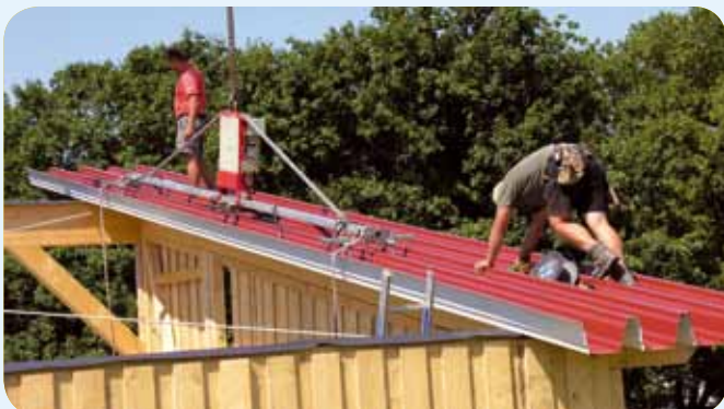
Schnelles Verlegen mit nur zwei Mitarbeitern
